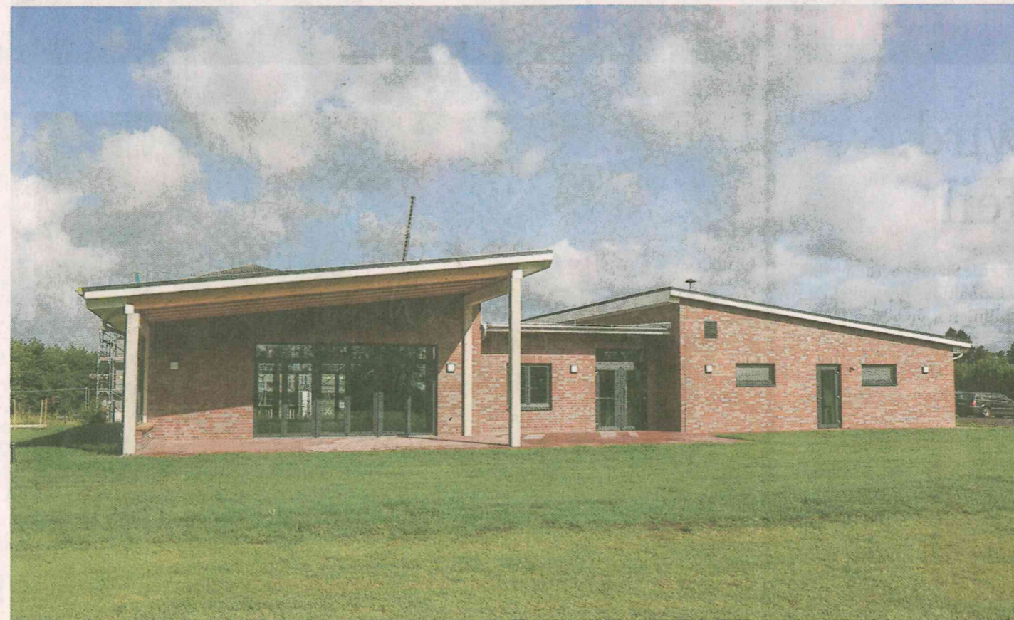
Zur Rückseite des neuen Sport- und Gemeindehauses schließt sich die verbliebene Rasenfläche des ehemaligen Sportplatzes an, der weiterhin für Sportangebote genutzt werden kann.
