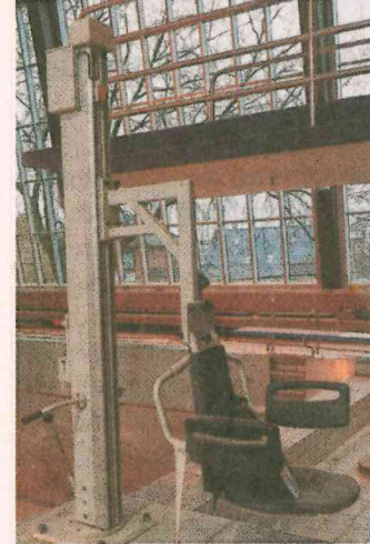
Dieser Lift stammt aus Elmshorn und ist für Badegäste gedacht, die über die Leitern nicht in das Schwimmbecken einsteigen können.
