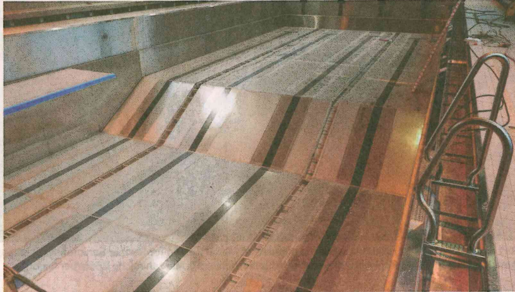
Verschweiß wartet es nun darauf, im Wasser unterzugehen, das 500 000 Euro teure Edelstahlbecken.
