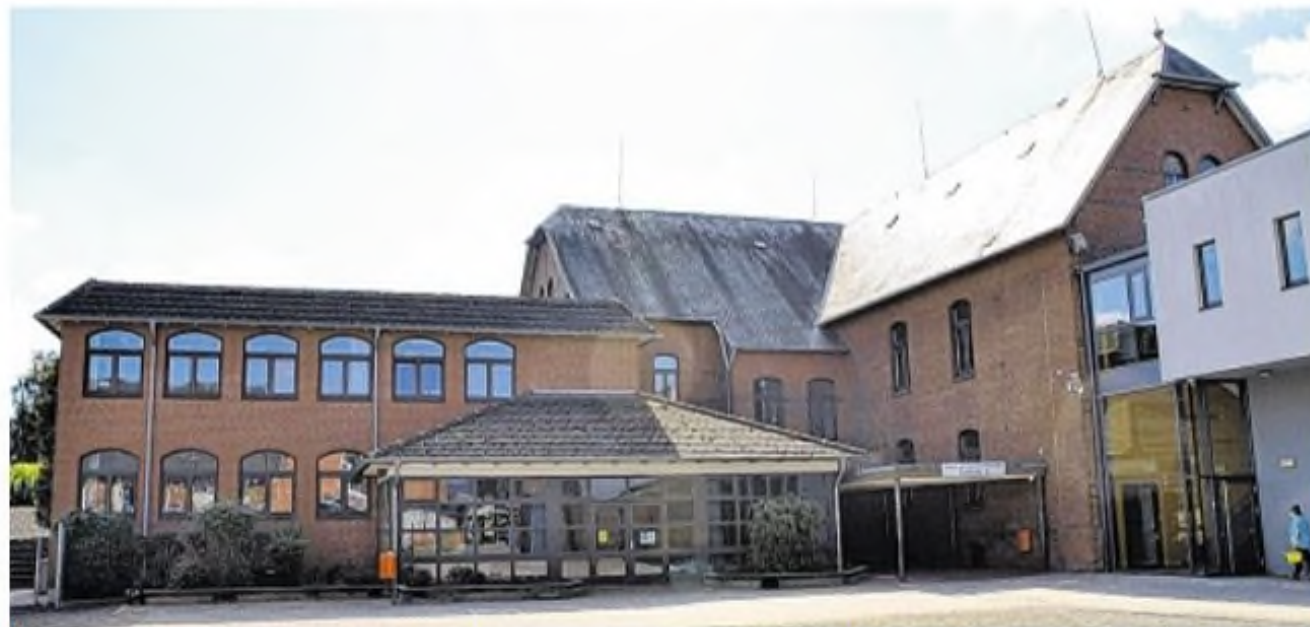
Barmstedts ehemalige Knabenschule wurde 1904 gebaut und 1996 erweitert. Im kommenden Jahr soll sie umfassend saniert werden. MEYER
