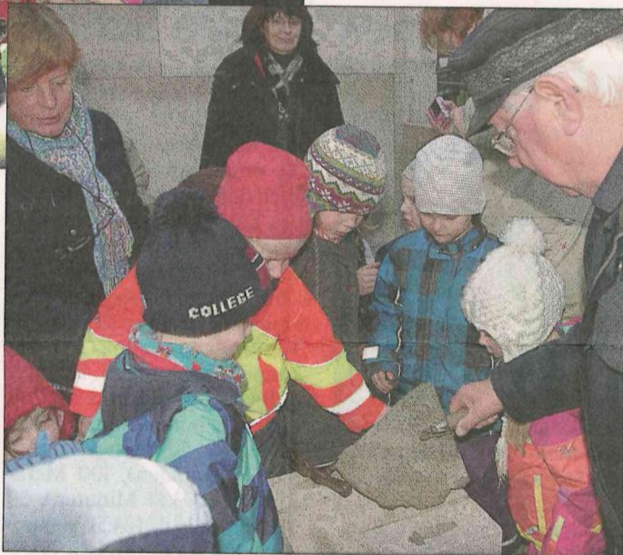
Mit großem Interesse sahen Kindergartenkinder Bürgermeister Udo Tesch bei der Grundsteinlegung zu. Und sie versprochen ihm, täglich zu verfolgen, was sich auf der Krippenplatz-Baustelle tut.
