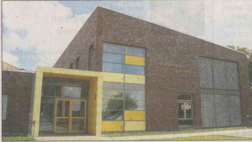
Der Neubau der Grundschule Horst fügt sich in kompakter Gestaltung, ausgestattet mit Verblendmauerwerk und Pultdach, harmonisch in die örtliche Umgebung ein. Fotos: Riethmüller
