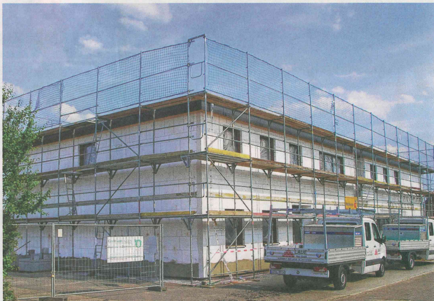
Eingerüstet: Noch bis Ende September/Anfang Oktober wird die Feuerwache modernisiert.
