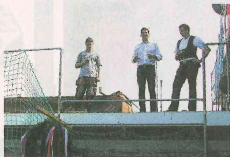
Am Gerätehaus wurde jetzt Richtfest gefeiert.
